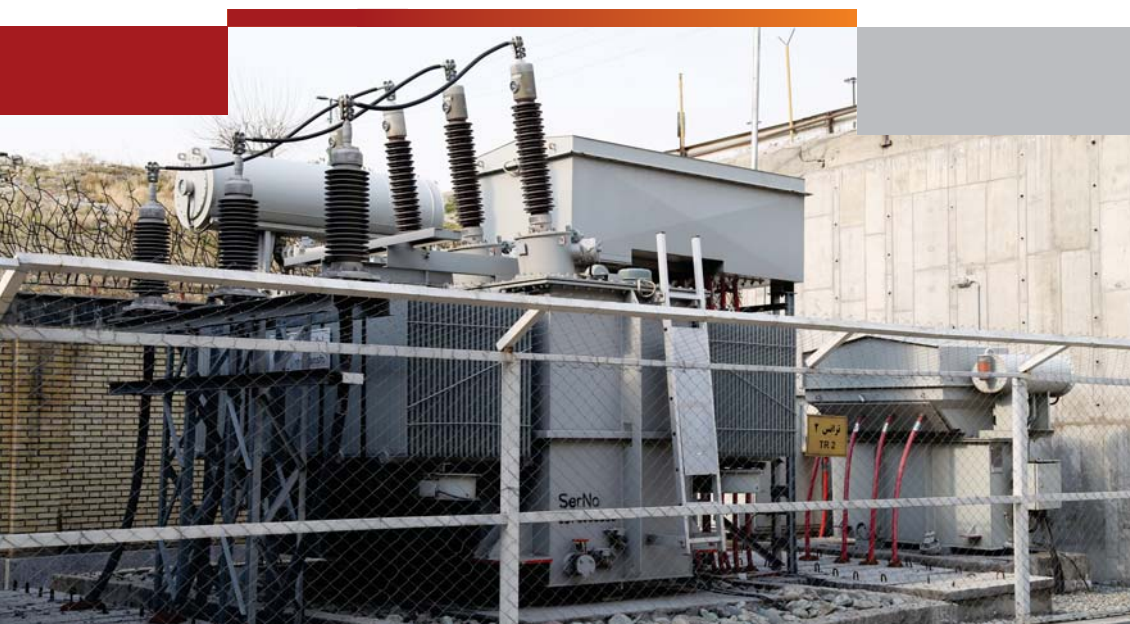
▲ ترانسفورماتور قدرت پست HVS
