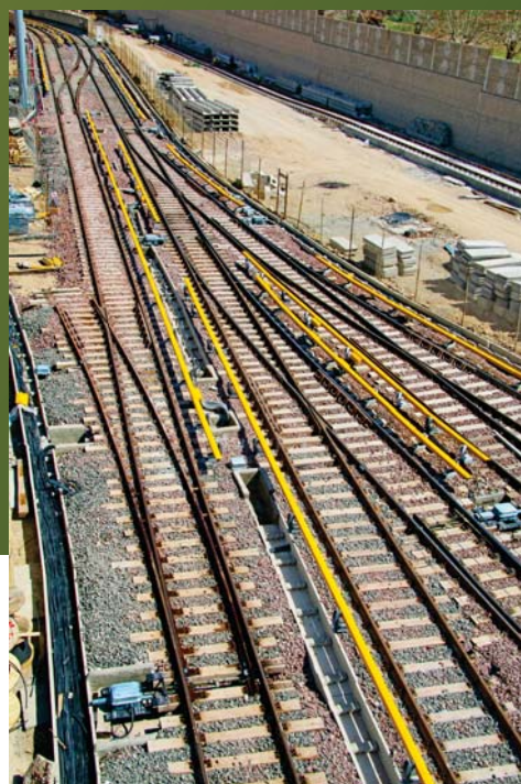
▼ ورودی پایانه شهید کلاهدوز - خط ۴ مترو تهران
